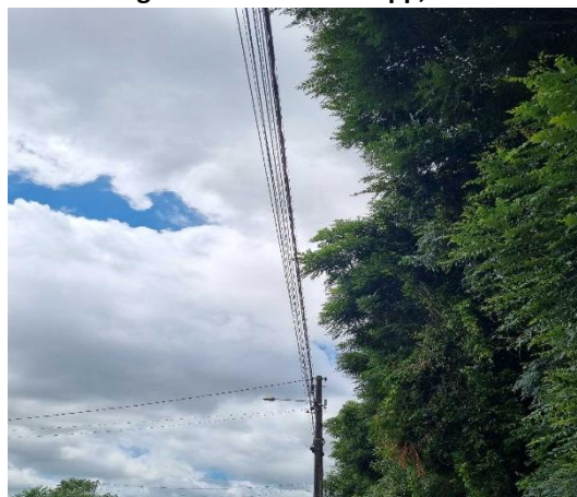
Figura 4 – Rua João Hepp, 490
